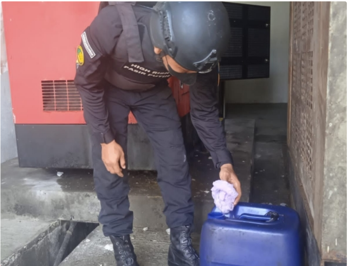
Petugas Lapas Pasir Putih laksanakan pengecekan bahan bakar solar untuk mesin genset
