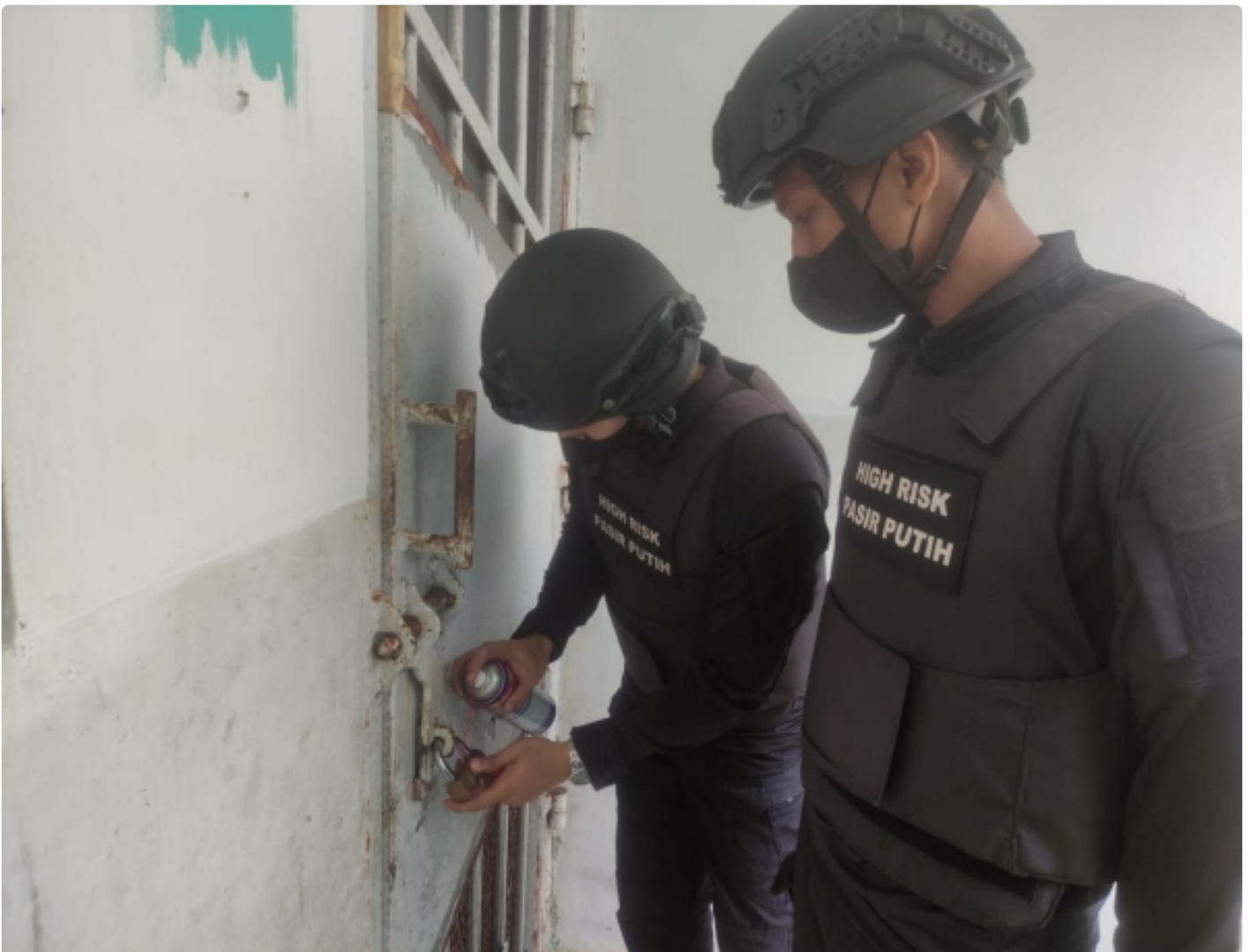
Petugas melaksanakan perawatan sarpras keamanan cegah korosi
